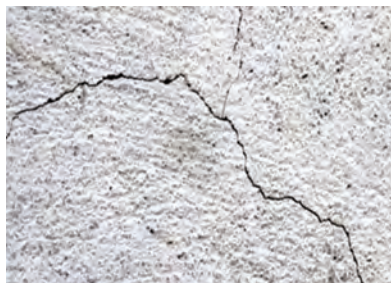
ترک خوردگی انقباضی بتن
