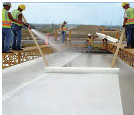
مرطوب کردن بتن و پوشش بانوار پلاستیکی
