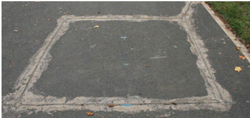
شکل ۲- نمونه نصب شده از حلقه‌های مغناطیسی
