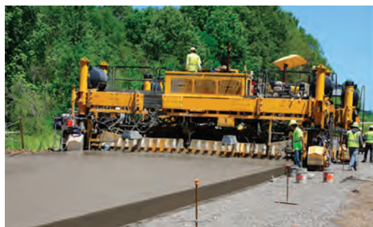
اجرای روسازی بتنی با استفاده از دستگاه
