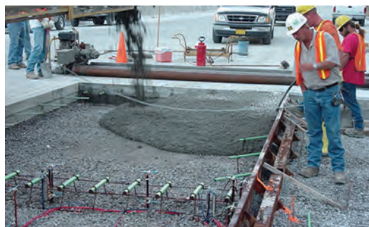
اجرای روسازی بتنی با استفاده از قالب‌بندی
