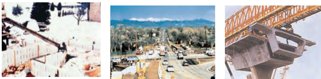
شکل ۳- سیمان‌های زودگیر، موارد استفاده (چپ به راست): بتن‌ریزی در هوای سرد، بهره‌برداری سریع از روسازی راه جهت به حداقل رسیدن ترافیک و باز کردن سریع قالب‌ها
