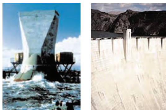
شکل ۴- استفاده از سیمان نوع ۴ در سد سازی
